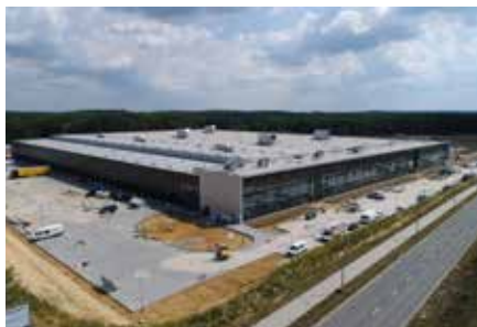
■ Hala wykonywana przez WPIP
