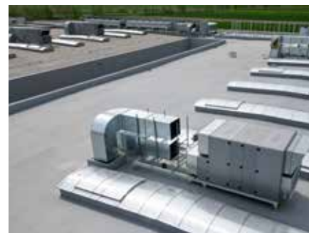
Hala wykonywana przez WPIP
