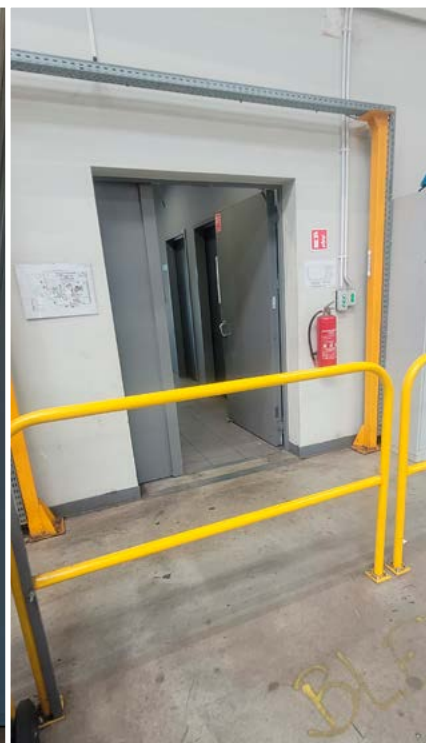
Zdj. 1. Przykład barierek zabezpieczających przed wtargnięciem pieszego na drogę transportową [z lewej widok od strony wejścia na halę; z prawej widok od strony hali]
